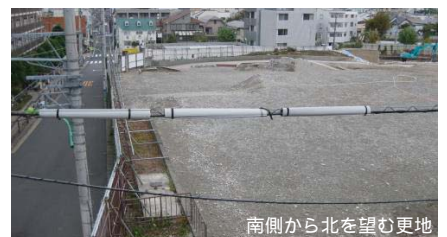
南側から北を望む更地
